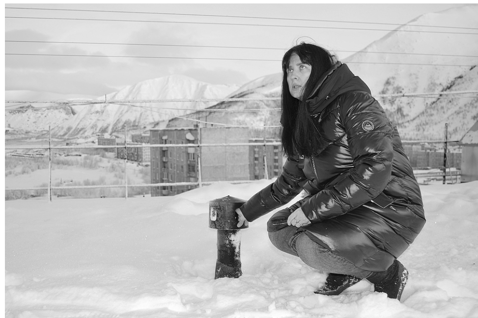
Людмила Крутяк: «Вот эти аэраторы позволяют теплоизоляционному слою дышать»
