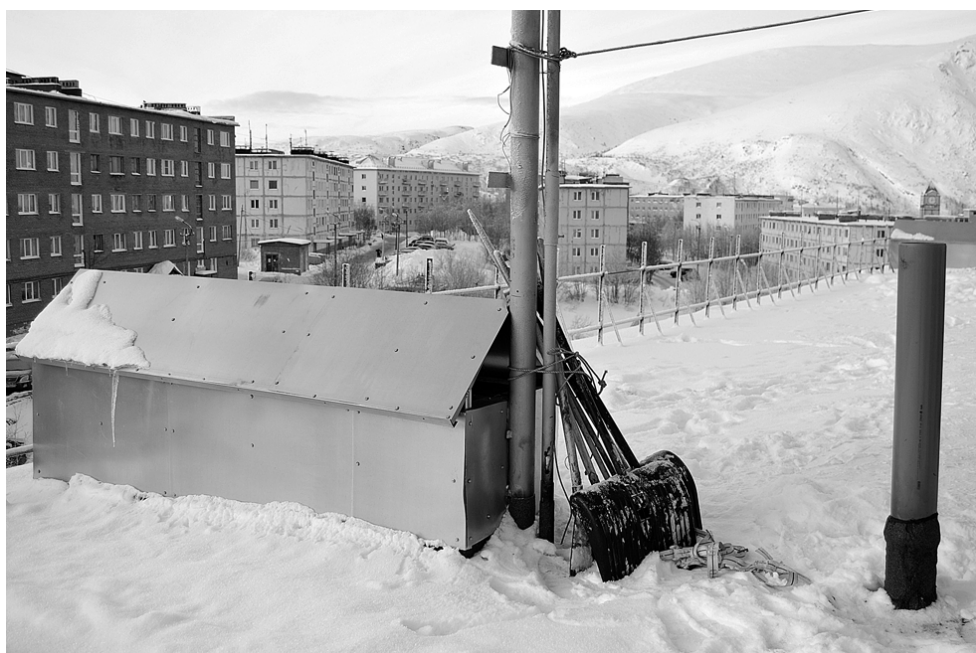
Уборка снега с крыши – ручной труд
