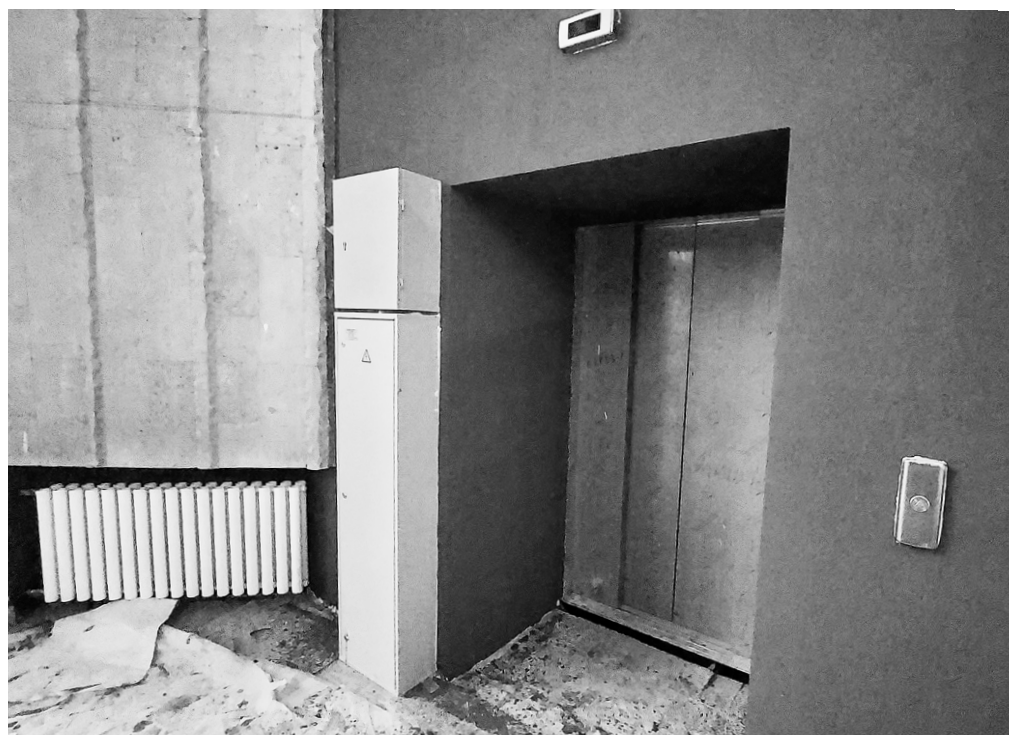
Лифт в библиотеке-музее – главное нововведение. После окончания капитального ремонта любоваться всеми залами и экспозициями смогут и маломобильные жители города
