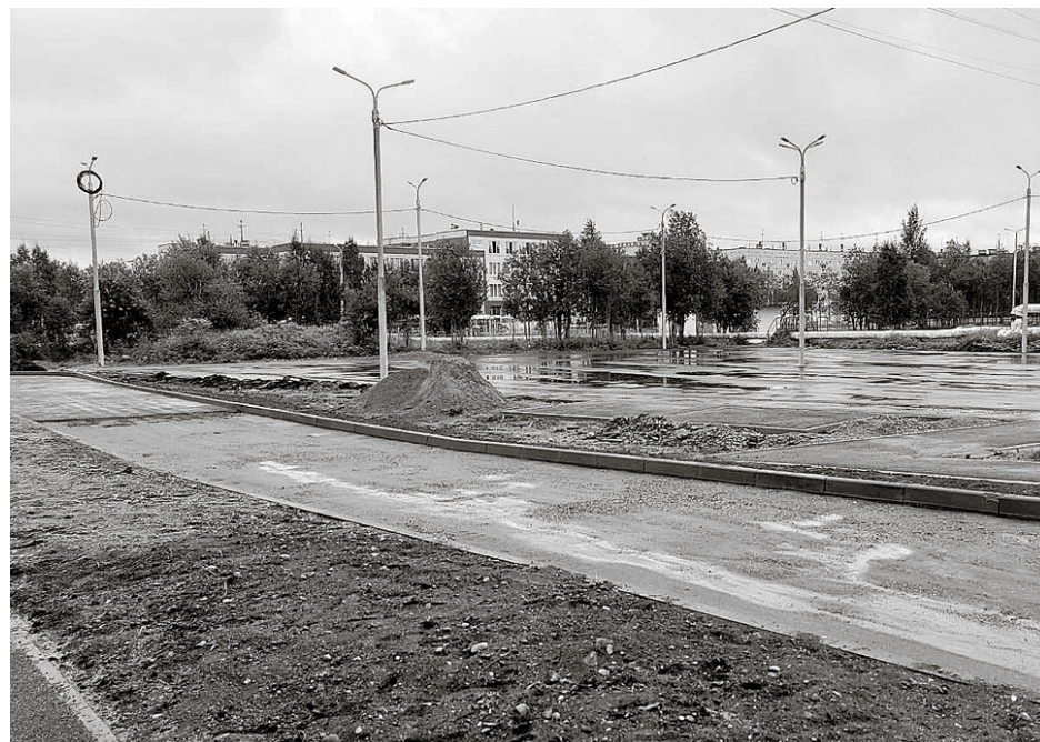
Второй этап благоустройства – покрытие площадки – почти завершён
