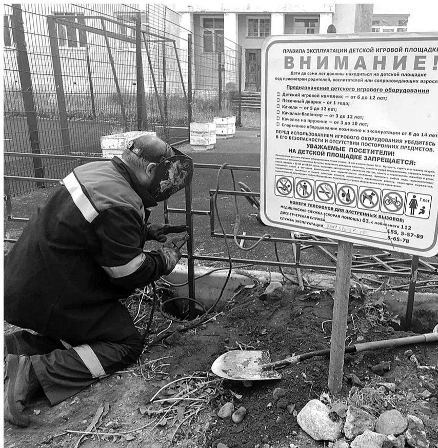
На этой площадке появится новое ограждение
