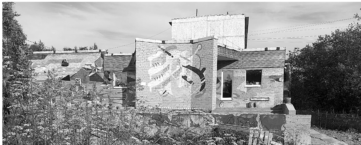
Для нескольких поколений апатитчан молодёжный социальный центр стал вторым домом. И после ремонта в нём будет ещё уютней!
