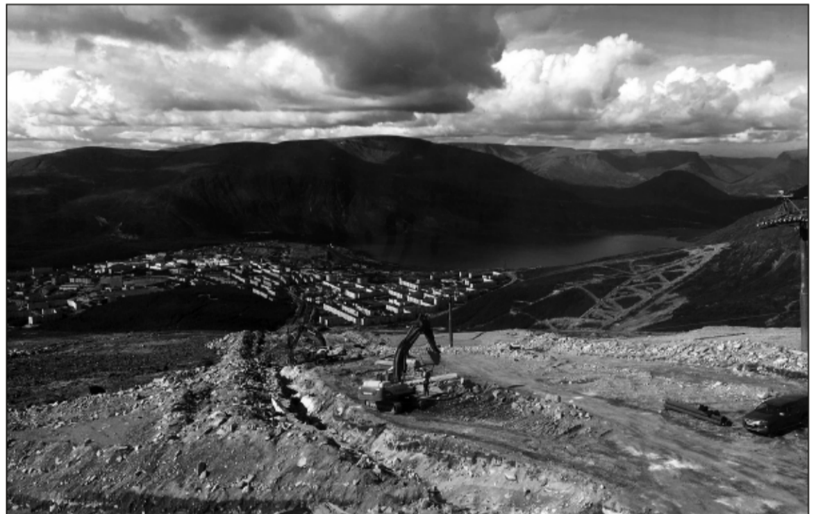
На северном склоне Айкуайвенчорра сейчас горячо: тут строят ресторан, к нему прокладывают водовод, а еще монтируют систему оснежения горнолыжных трасс. Фото из группы «Минстрой Мурманской области».
