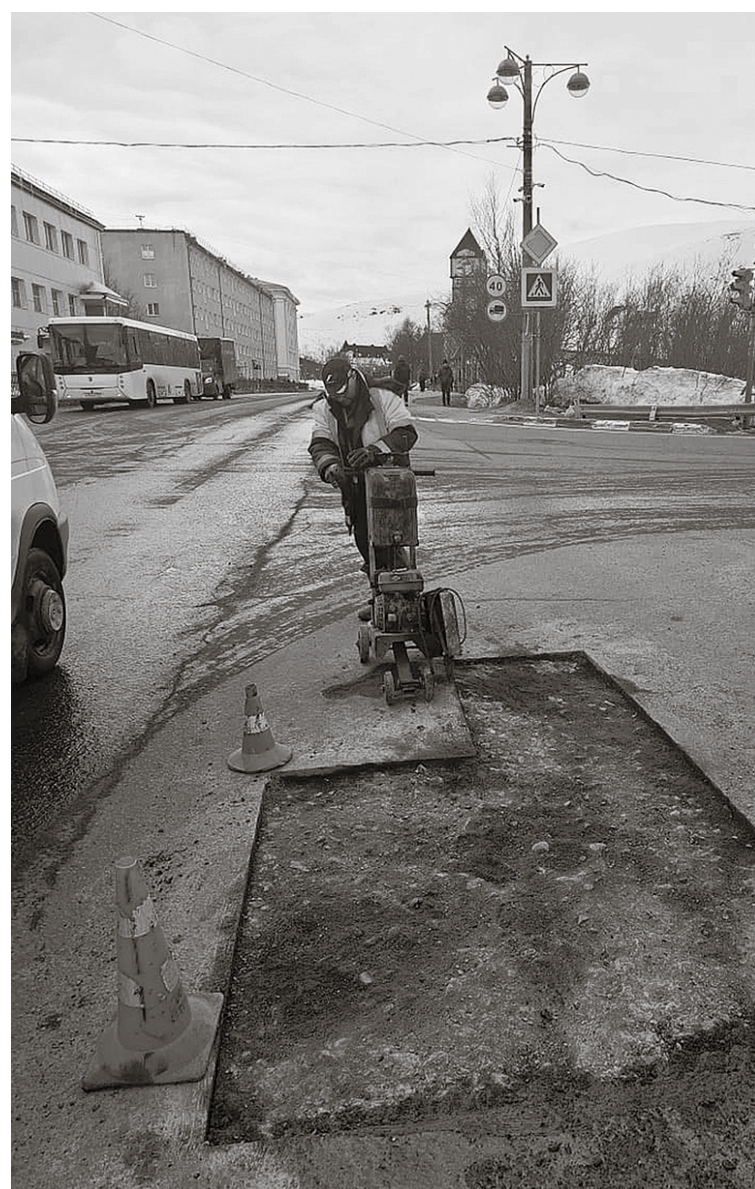
В Кировске продолжается ямочный ремонт городских дорог
