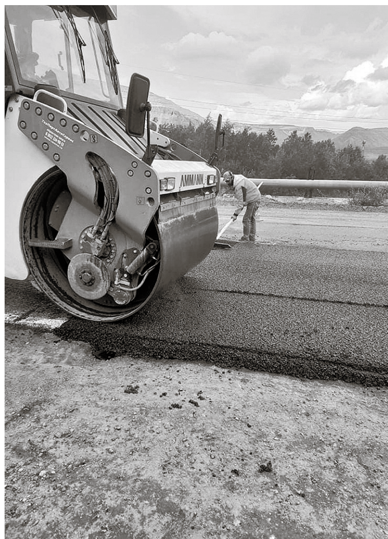
Дороги покроют износостойким асфальтобетоном
