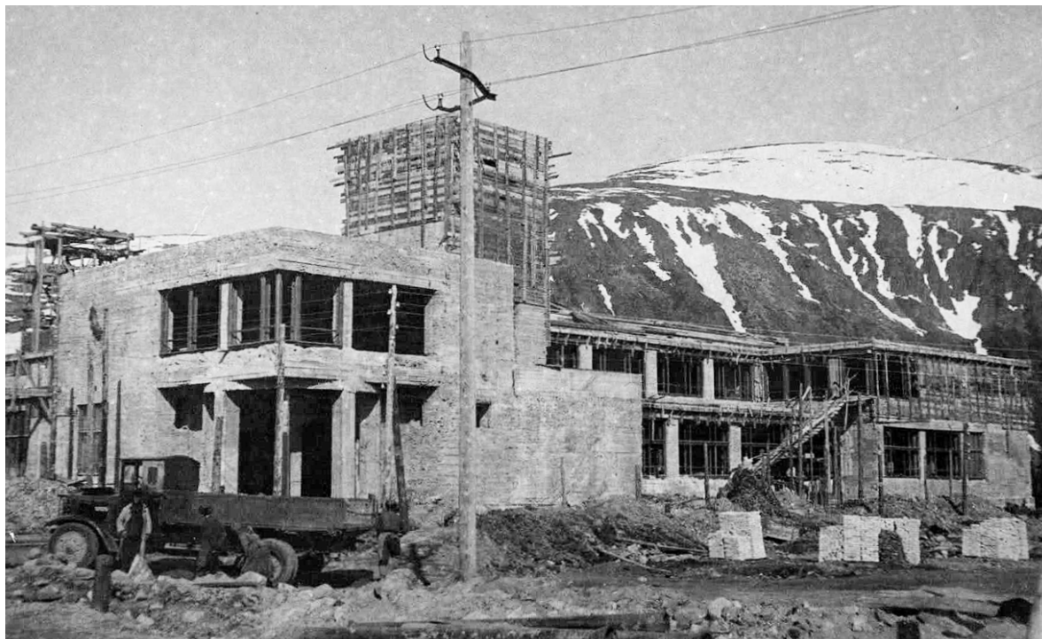
Строительство кинотеатра «Большевик» в г. Хибиногорске, май-июнь 1932 г.
