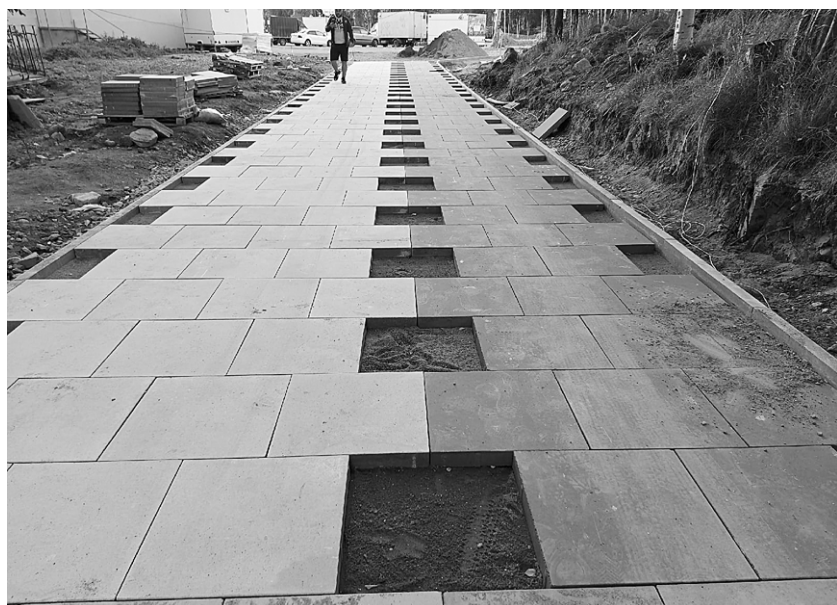
Тротуарная плитка выдержит испытания холодом благодаря температурным швам
